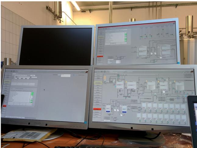
Der Braumeister kann auf mehreren Monitoren mit allen Überwachungsinformationen den gesamten Fertigungsprozess überblicken.
