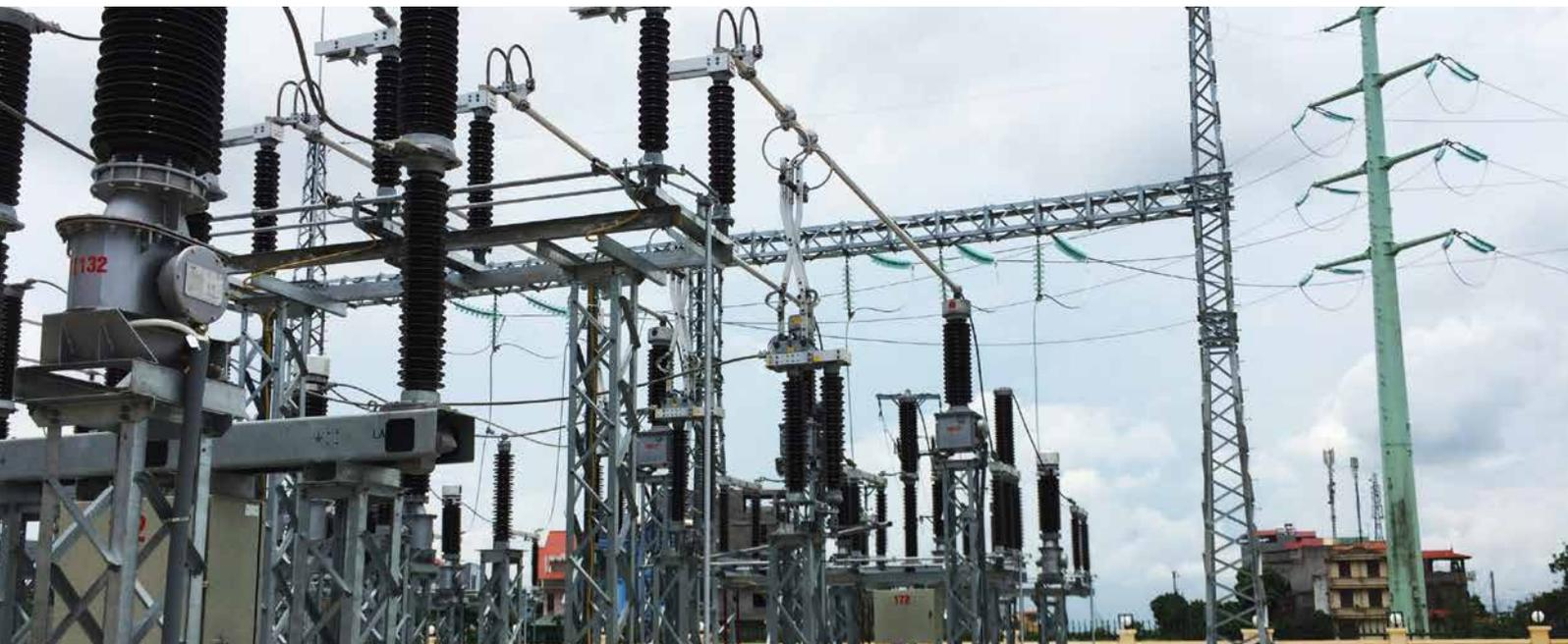
Innerhalb Vietnams staatlicher Elektrizitätsgesellschaft ist die EVN Hanoi für die Versorgung der Region Hanoi zuständig. PETROLEC, ein vietnamesischer COPA-DATA Distributor, unterstützte die EVN maßgeblich bei der Implementierung eines neuen, zenon-basierenden Steuerungssystems in mehr als 30 ihrer 110-kV-Umspannwerke.
